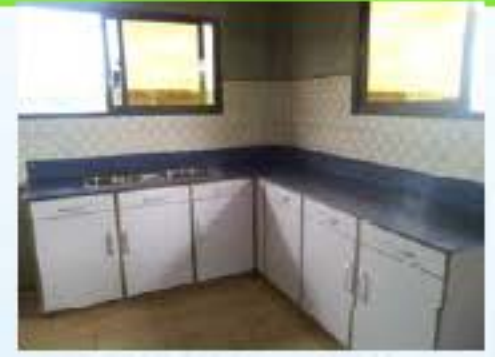
Foto: renovatie van de keuken
