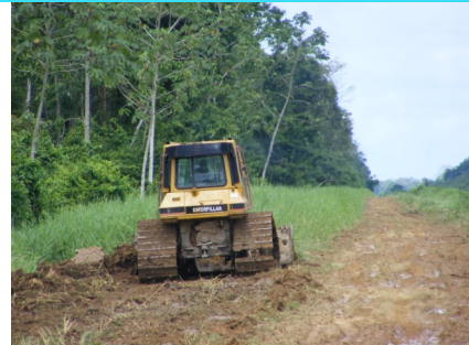
Foto: OWMCP heeft thans een bulldozer in gezet om de weg naar kamp 13 aan te pakken
