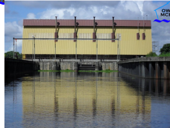
Foto: De buitenkant van het gemaal is ook van een nieuwe verlaag voorzien
