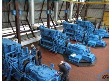
Foto: De vier Storkmotoren die er prachtig uitzien na de algehele revisie
