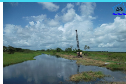
Foto: Een dragline bezig met het opschonen van de Nanikreek
