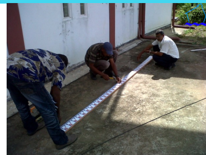
Foto: Medewerkers OWMCP bezig een peillat te plaatsen bij de instroomzijde van het Clarapompgebied in de Westelijke polders
