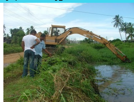
Foto: Een graafmachine tijdens de rehabilitatie van waterschap Van drimmelpolder
