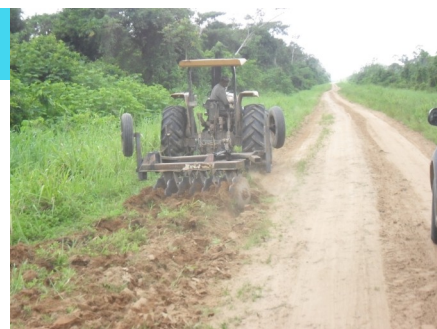
Foto: Mewerkers van OW MCP bezig met onderhoudswerkzaamheden op de weg naar kamp 13
