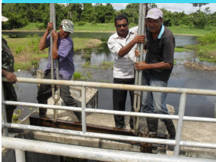
Foto: Medewerkers van OW MCP bezig schotbalken te verwijderen bij de overlaat te Zuid-drain.
